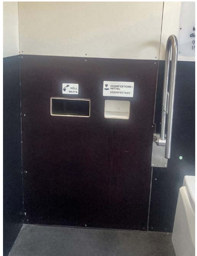
Abbildung 19: Innenansicht des Modells Autark+Modular nach dem Ausbau des Waschbeckens (Bild: SenMVKU)
